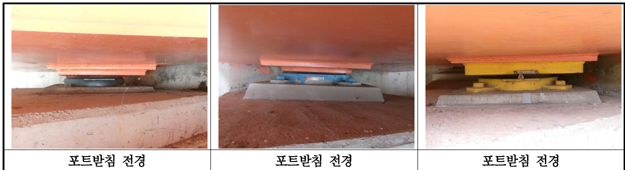
【사진 22.3.32】 교량받침 전경
