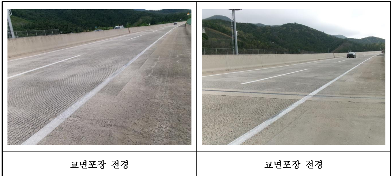
【사진 22.3.39】 교면포장 전경
