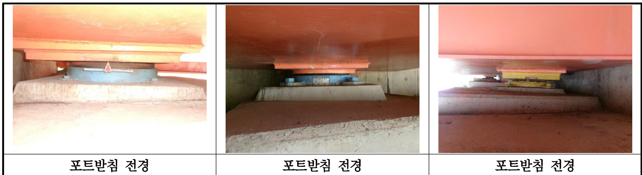
【사진 22.3.10】 교량받침 전경
