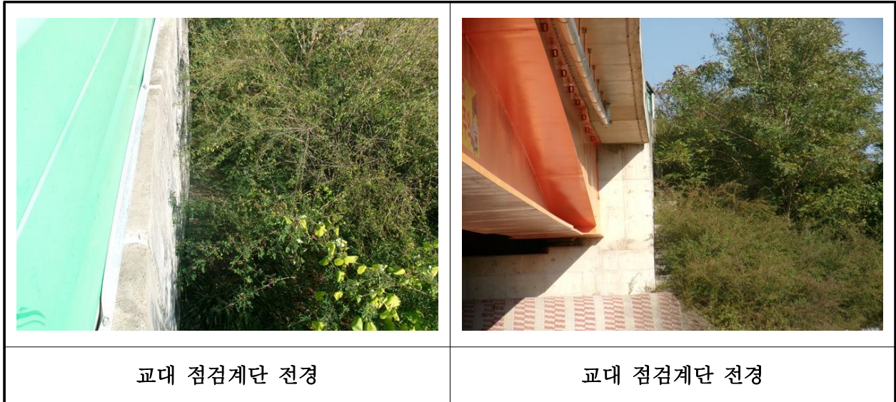
【사진 22.3.45】 교량 점검시설 전경
