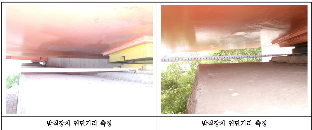
【사진 22.3.12】 교량받침장치 연단거리측정
