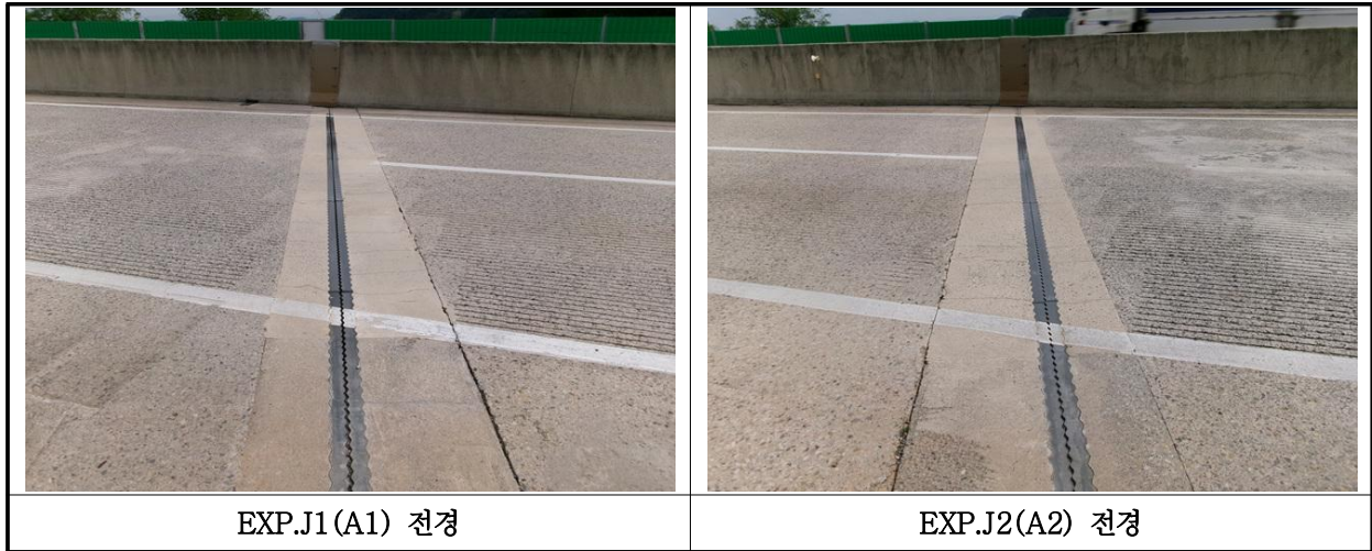
【사진 22.3.14】 신축이음장치 전경
