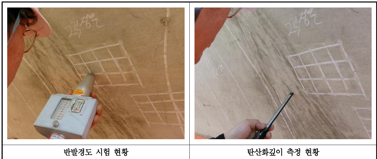
【사진 22.4.1】 콘크리트 내구성조사 현황
