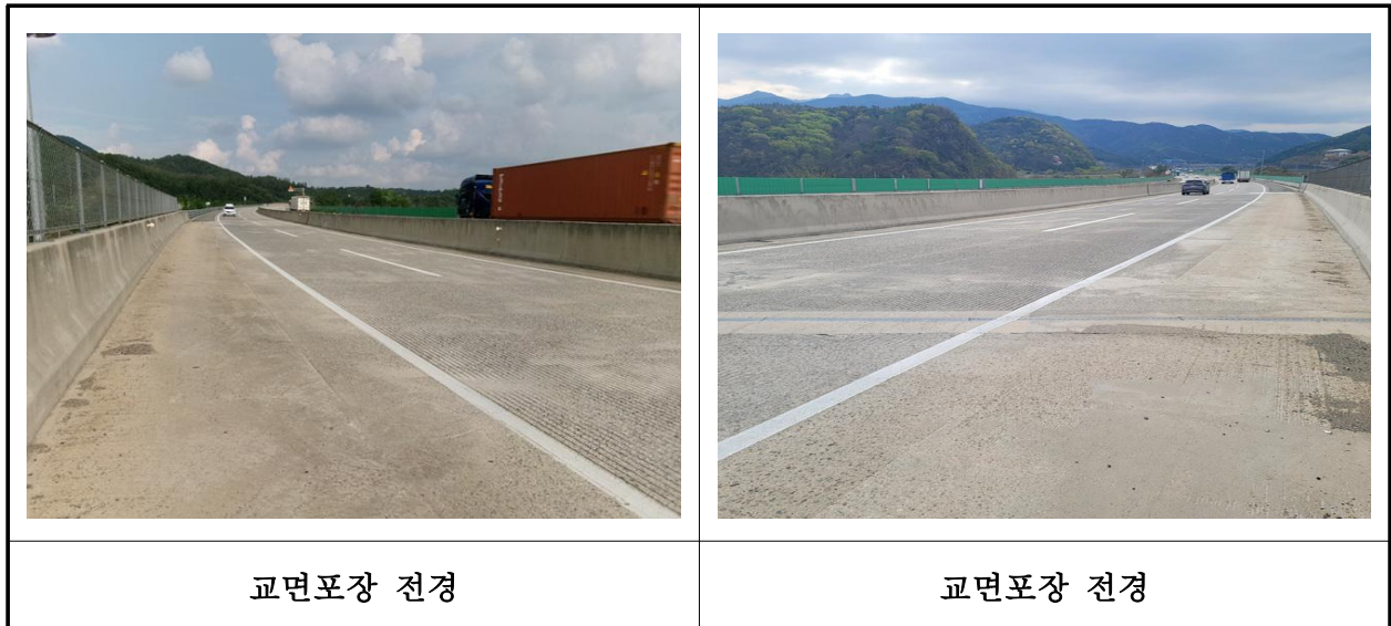
【사진 22.3.17】 교면포장 전경
