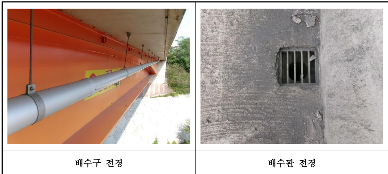
【사진 22.3.41】 배수시설 전경
