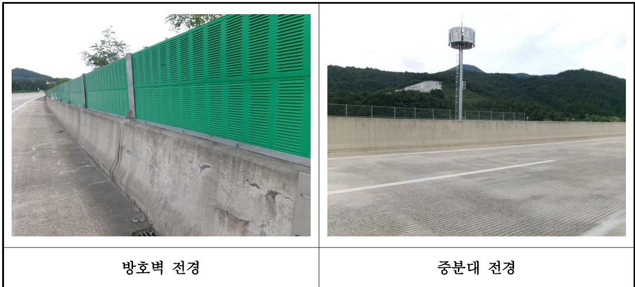
【사진 22.3.43】 방호벽 및 중앙분리대 전경
