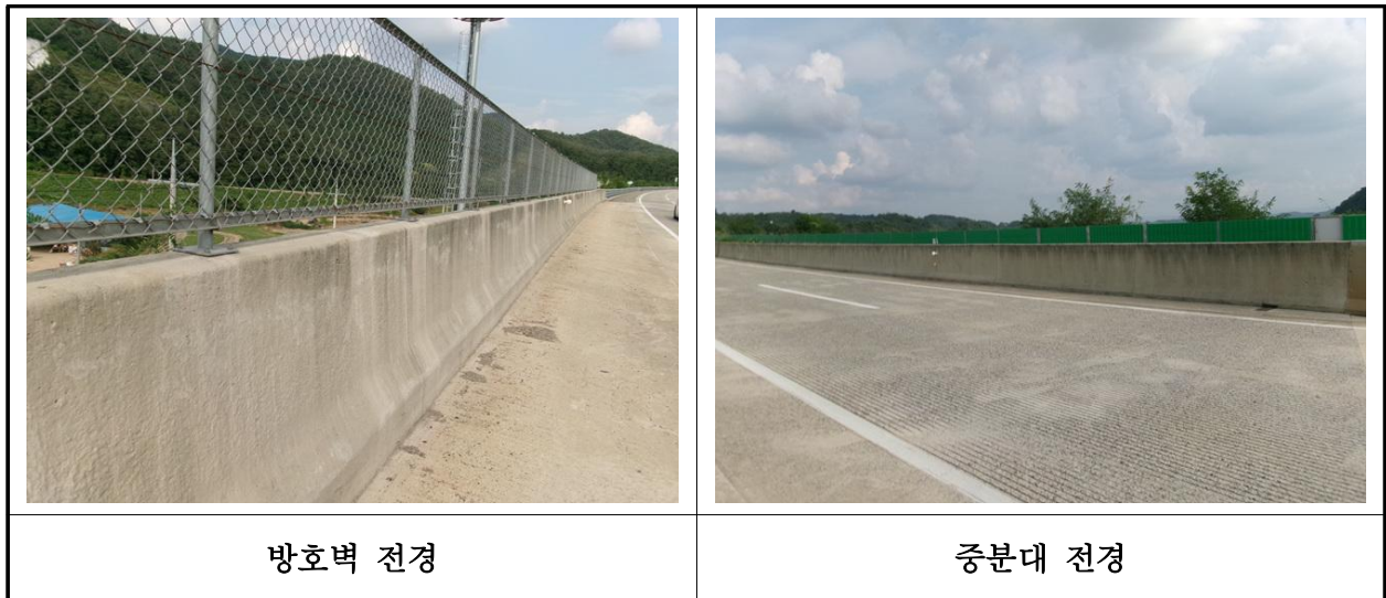
【사진 22.3.21】 방호벽 및 중앙분리대 전경
