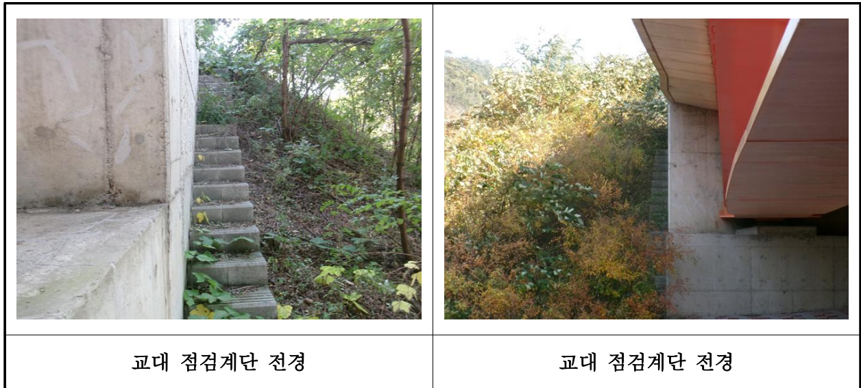
【사진 22.3.23】 교량 점검시설 전경
