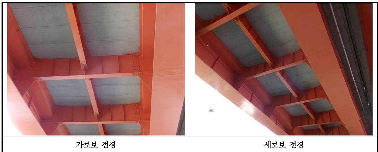
【사진 22.3.6】 가로보 및 세로보 전경
