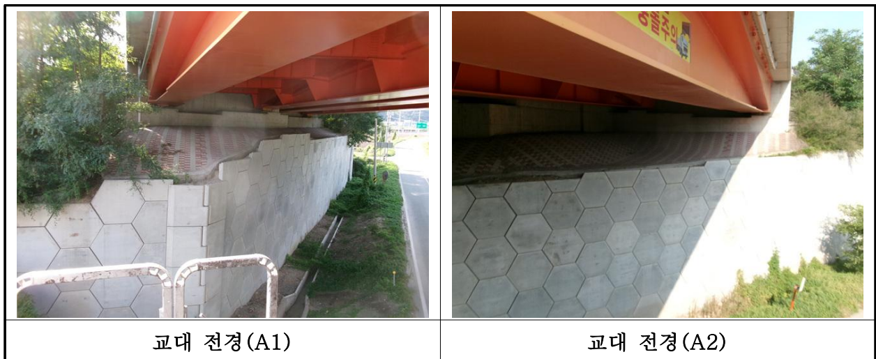
【사진 22.3.30】 교대 전경
