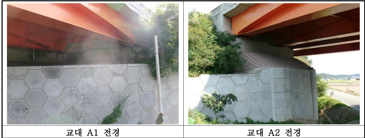
【사진 22.3.8】 교대 전경
