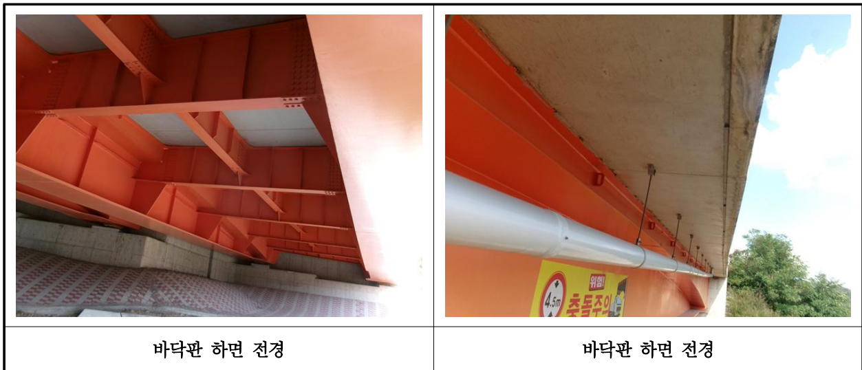
【사진 22.3.25】 바닥판하면 전경
