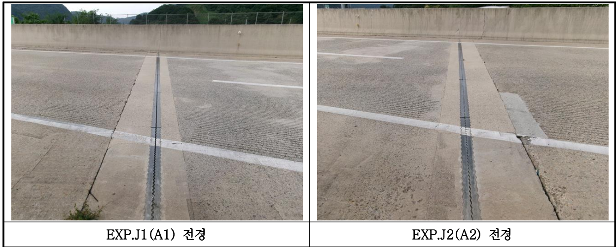
【사진 22.3.36】 신축이음장치 전경
