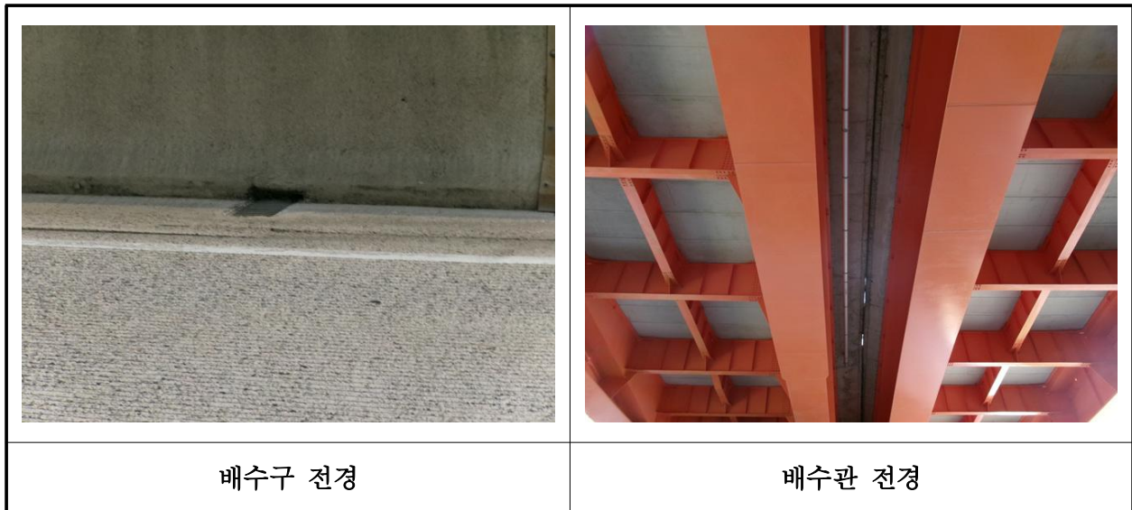
【사진 22.3.19】 배수시설 전경
